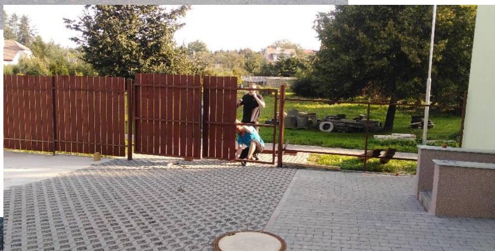
Instalace oplocení u sběrného dvora
