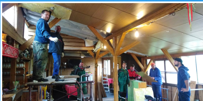
Brigáda - zateplení střechy hospody
